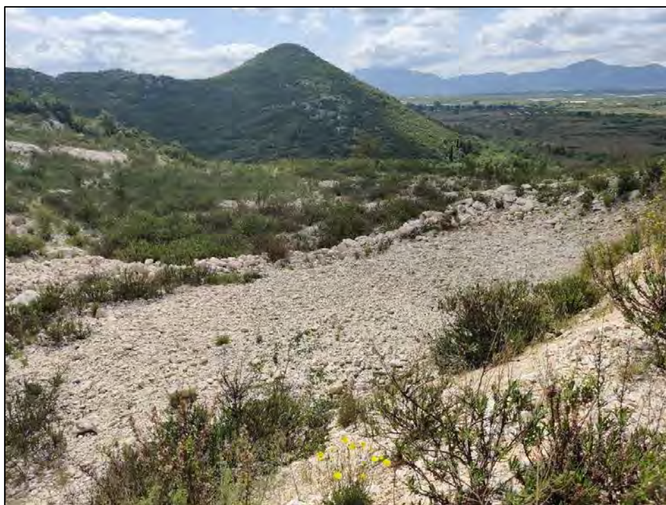
Slika 8. Prikaz postojećeg stanja deponije Petrovac (4), Izvor: Tehničko rješenje sanacije deponija iskapanog materijala „Petrovac“ uz autocestu A1 Zagreb – Split – Dubrovnik, spojna cesta Ploče – luka Ploče, šumarija Metković (grupa II), BOLD d.o.o., lipanj 2021.
